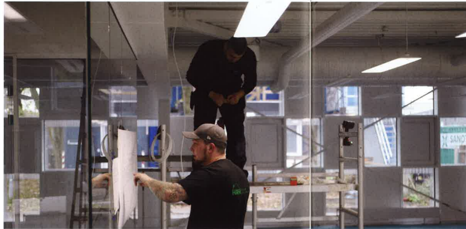
HRH El er installatør på opgaven med opsætning af 400 intelligente armaturer fra Phillips Lighting.
